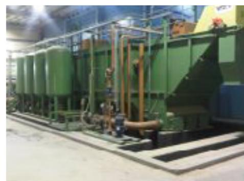
Il sistema LIQUID VACUUM SANDWICH PANEL, di seguito LVSP, nasce per fare fronte alle richieste di avere dei gradi di filtraggio spinti, costanti nel tempo, unitamente alla riduzione dell'impatto ambientale.
